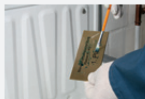
Messingoxyd mit einem Pinsel einwirken lassen.
